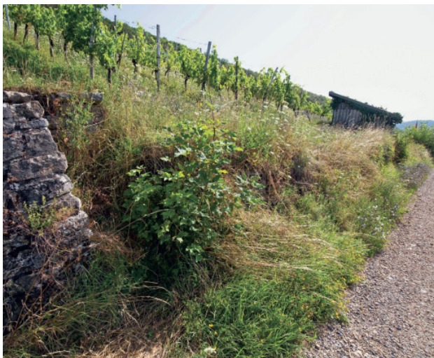
Abbildung 1: Die stark zerfallene und überwachsene Mauer war vor der Sanierung kaum noch zu erkennen (Bild: Noah Meier, creaNatira GmbH)
