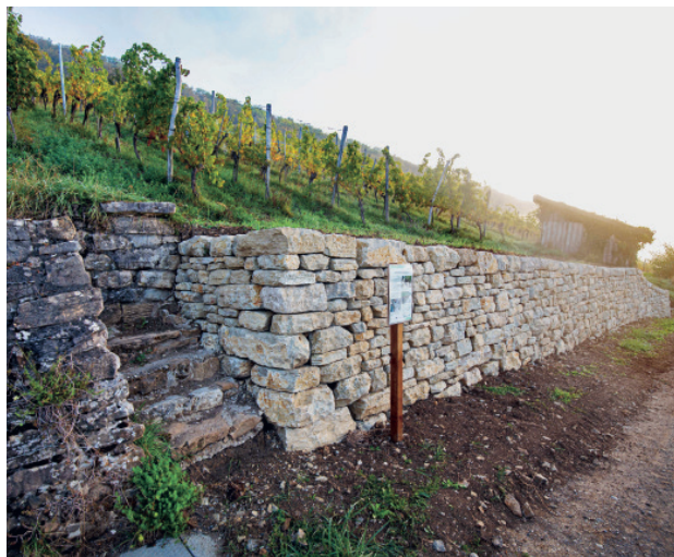
Abbildung 2: Nach der Sanierung zeigt sich die Trockenmauer in einem strukturreichen Fugenbild. (Bild: Noah Meier, creaNatira GmbH)
